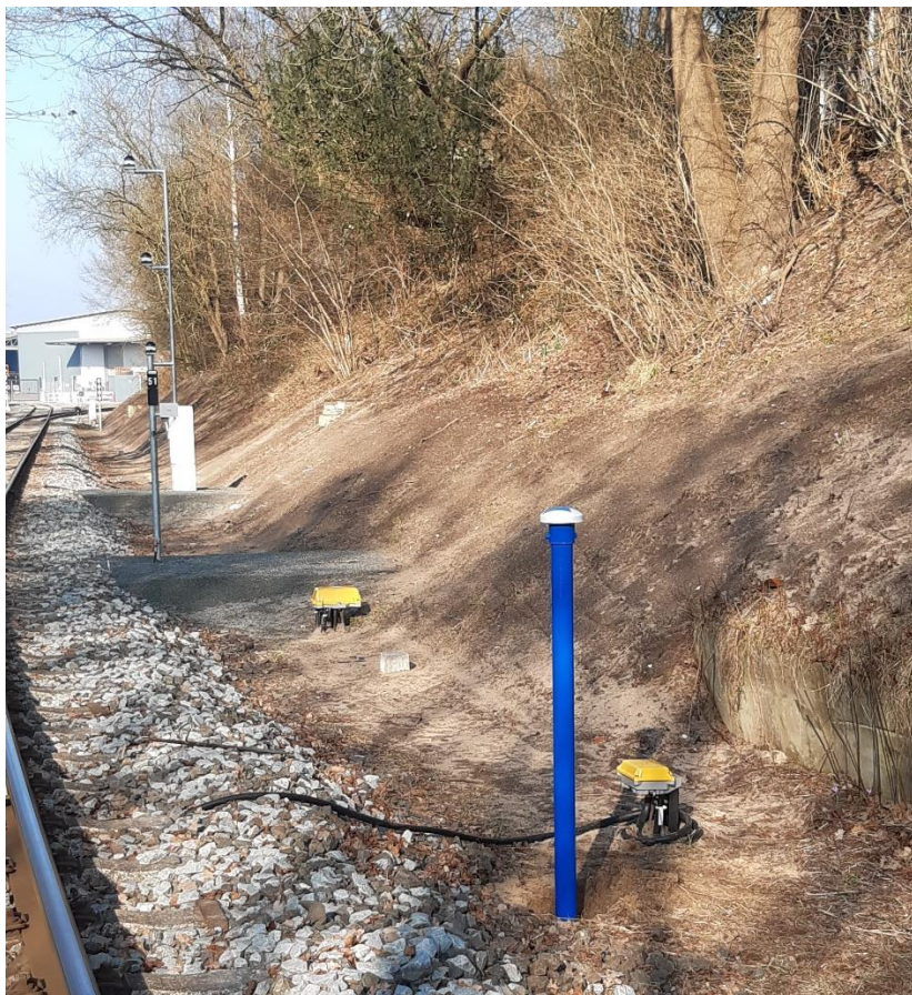
Abbildung 5: Merkpfehl für Kontakt DSS 1 (für Richtungswechsel freifahren)
